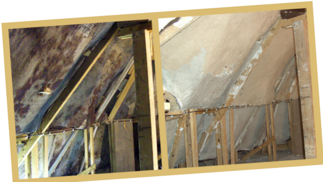
Um die Anlage zu stabilisieren, musste sie von unten vergipst werden. 150 Kilogramm Gips wurden dazu in einer Woche verbraucht.
