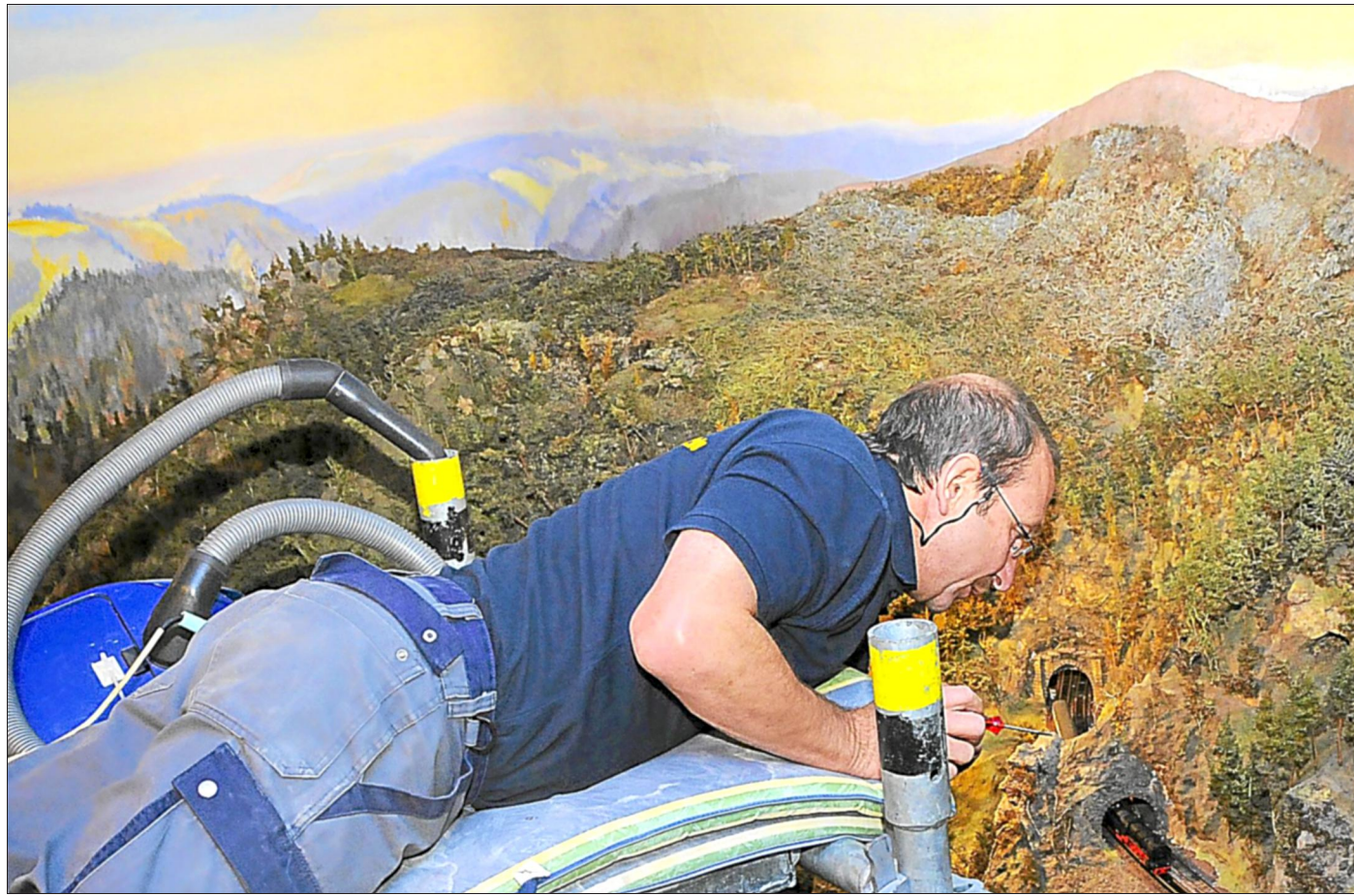
Von einem Spezialgerüst aus konnte Roland Weber die Gleise liegend entfernen – und die neuen wieder anbringen. Foto: Kienzler
